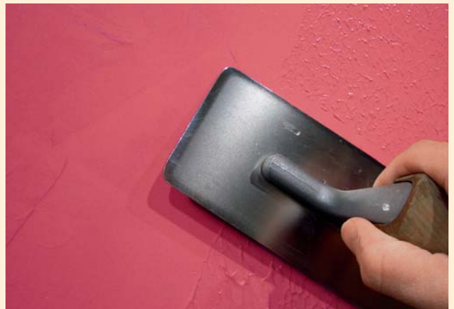
4) Abglätten unmittelbar nach dem Rollauftrag, überschüssiges Material scharf abziehen
