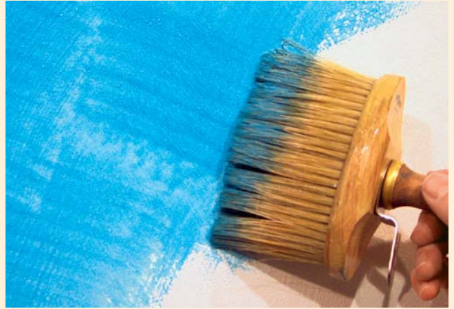
2) Auftrag setta creativo BRILLANT LASURFARBE Florenz mit der Streichbürste im Kreuzgang
