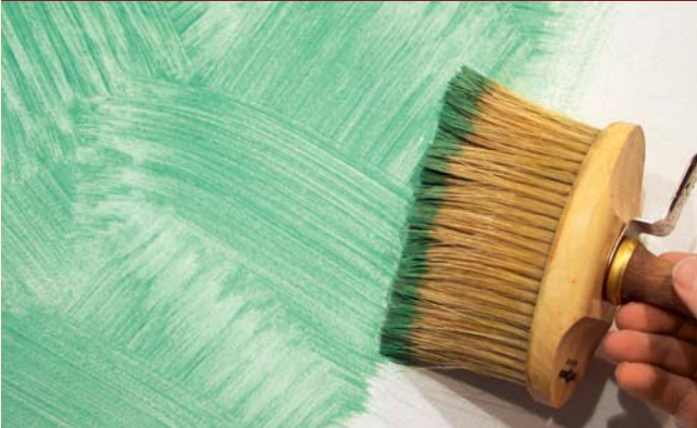
1) Auftrag mit der Streichbürste im Kreuzgang
