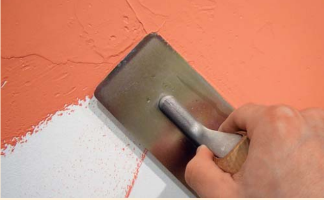
1) Vollflächiger Auftrag mit der Venezianerkelle
