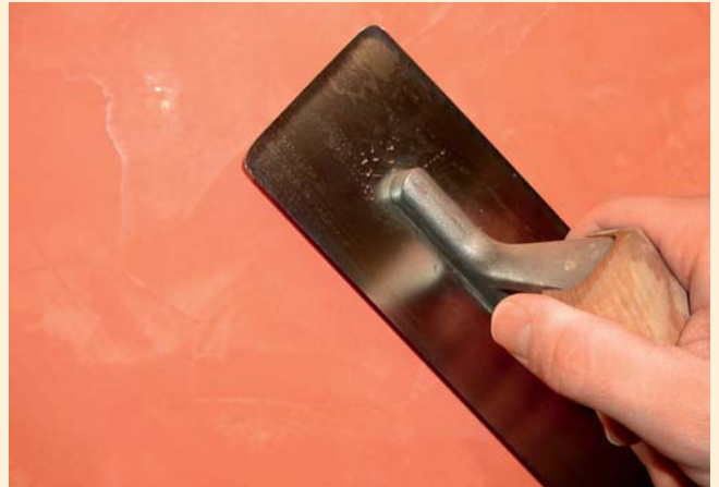
4) Verpressen der Oberfläche. Auf der noch nassen Fläche nur leichten Druck ausüben, später den Druck erhöhen
