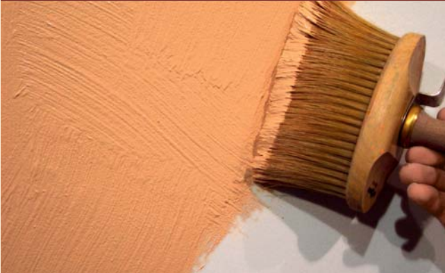
1) Auftrag setta Silikat Streichputz mit der Streichbürste im Kreuzgang
