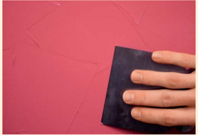
2) Einarbeiten einer leichten Struktur (Kellenschläge)
