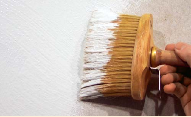
1) Auftrag setta WP Streichgrund mit der Streichbürste im Kreuzgang
