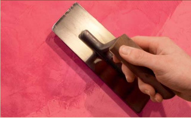
1) Auftrag mit der Venezianerkelle in dünner Schicht auf setta creativo MINERALISCHE SPACHELTECHNIK Venedig
