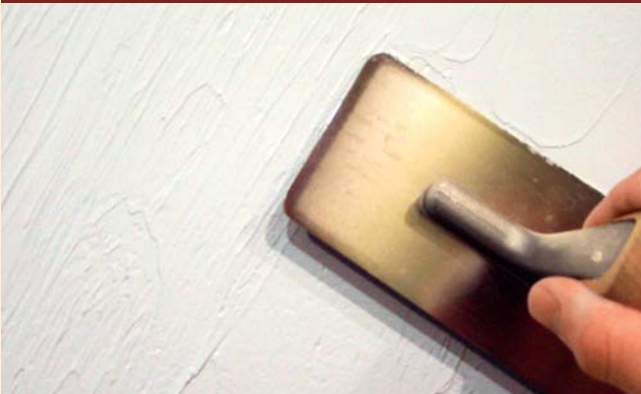
1) Grau getönter Auftrag in diagonaler feiner Reliefstruktur
