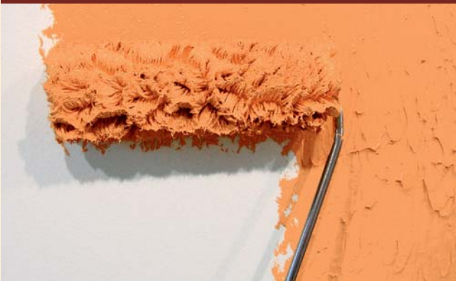
1) Vollflächiger Auftrag mit der Farbrolle
