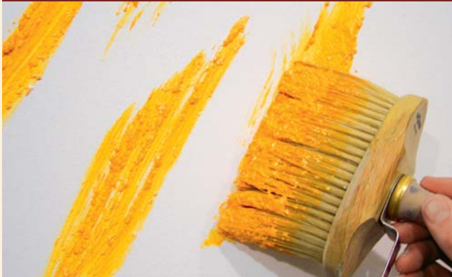
1) Diagonaler Auftrag mit der Streichbürste
