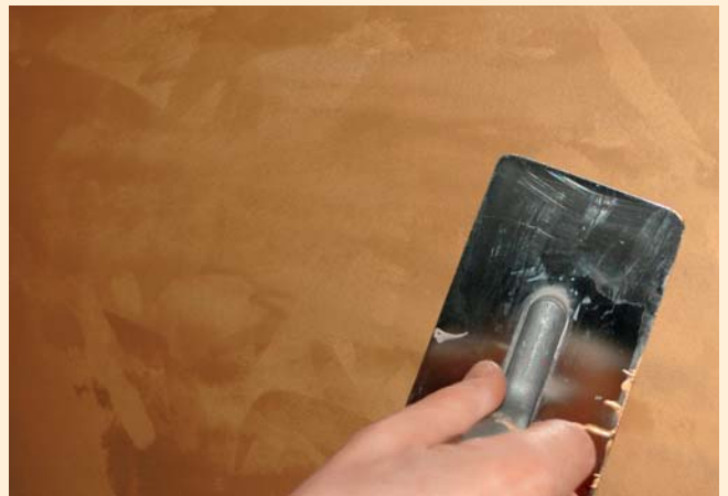
2) Beim Aufzug in mehrere Richtungen arbeiten
