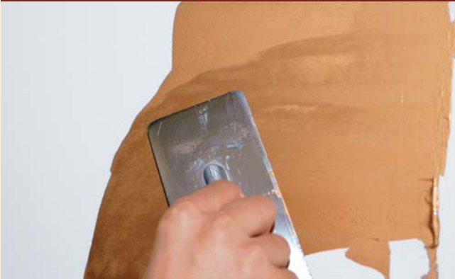
1) Auftrag mit der Venezianerkelle auf eine geglättete Fläche setta Innenspachtel Leicht
