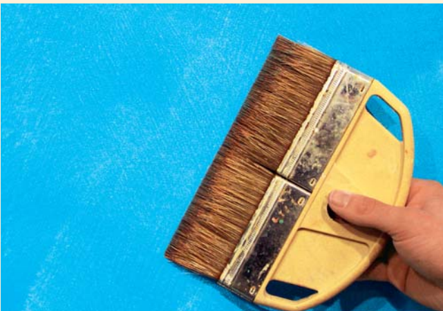
3) Unmittelbar nach dem Auftrag kann die Lasur mit einer weichen Bürste (Vertreiber) verschlichtet werden
