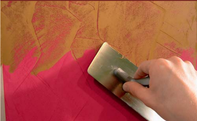
1) Auftrag mit der Venezianerkelle, überschüssiges Material sofort abziehen
