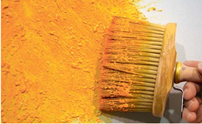
1) Auftrag mit der Streichbürste im Kreuzgang
