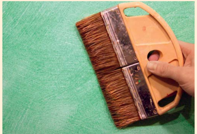
2) Unmittelbar nach dem Auftrag kann die Lasur mit einer weichen Bürste (Vertreiber) verschlichtet werden
