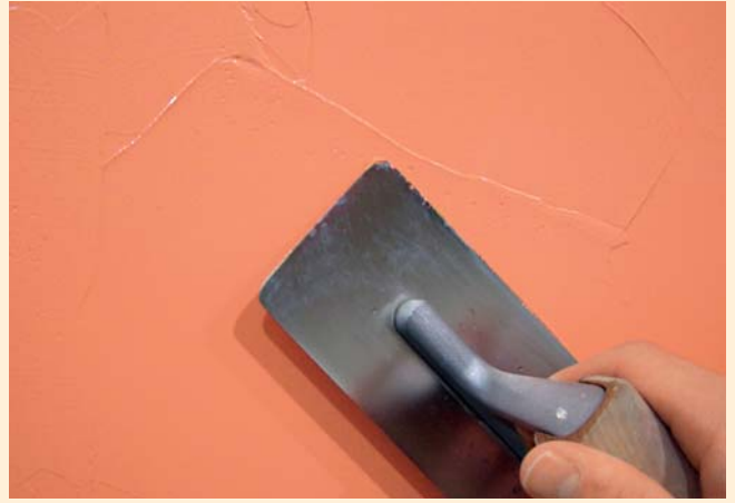
2) Einarbeiten einer leichten Struktur (Kellenschläge)
