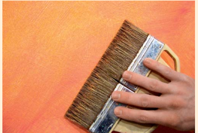
4) Unmittelbar nach dem Auftrag kann die Lasur mit einer weichen Bürste (Vertreiber) verschlichtet werden.
