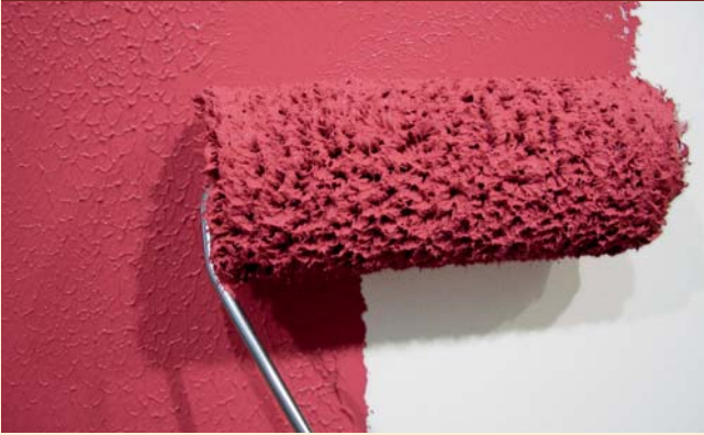
1) Vollflächiger Auftrag mit der Farbrolle
