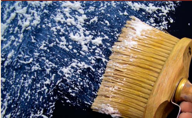
Auftrag mit der Streichbürste im freigeführtem Kreuzgang
