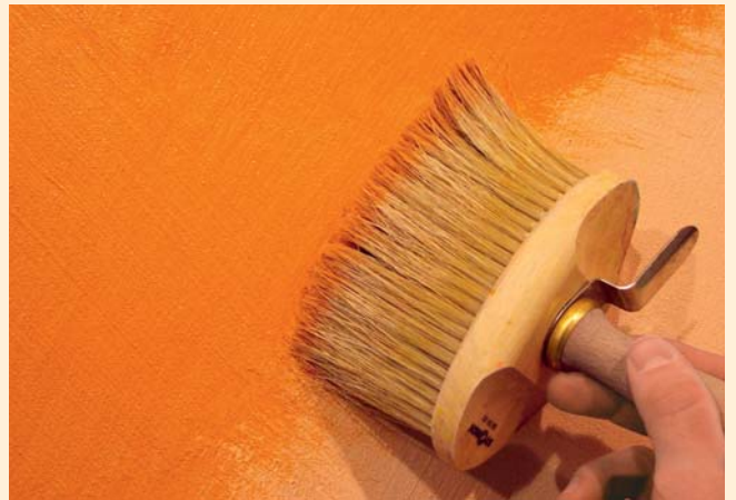
2) Auftrag setta creativo SILICAT-LASUR Palermo mit der Streichbürste im Kreuzgang
