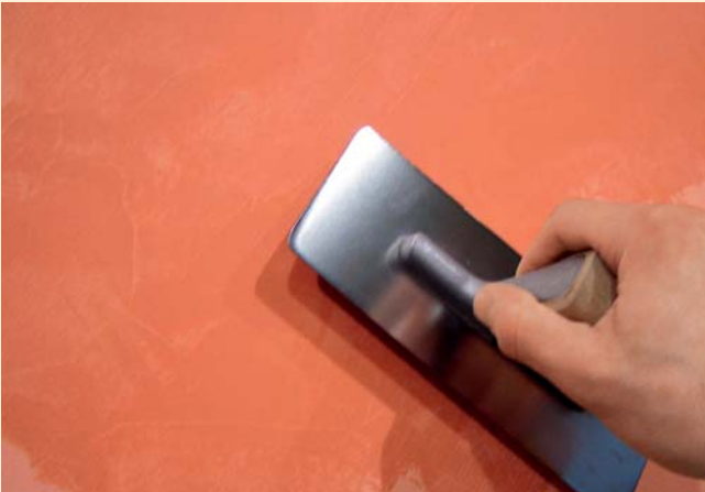
3) Zweiter Auftrag, das Material wird glatt abgezogen
