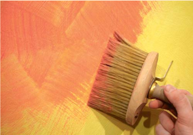
3) Zweiter Auftrag setta creativo SILICAT-LASUR Palermo mit der Streichbürste im Kreuzgang
