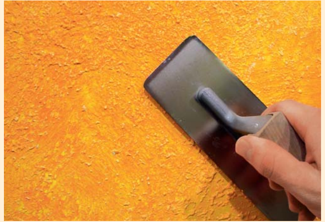
2) Unter leichtem Druck nachglätten mit einer Venezianerkelle
