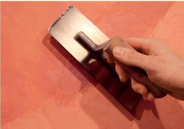
5) Vollflächiger Auftrag setta creativo Wachs Finish Neapel
