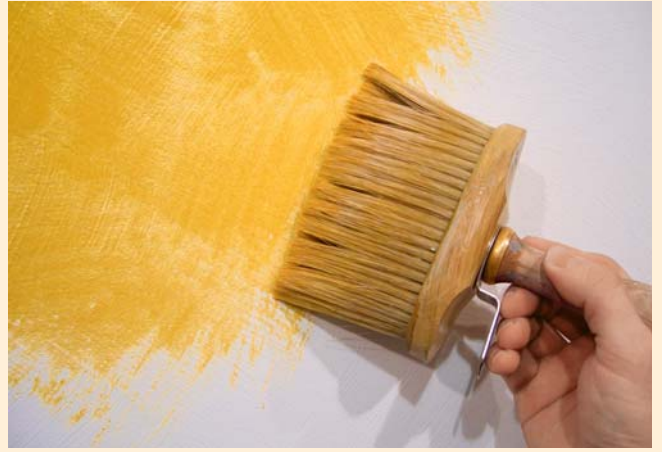
2) Erster Auftrag setta creativo SILICAT-LASUR Palermo mit der Streichbürste im Kreuzgang
