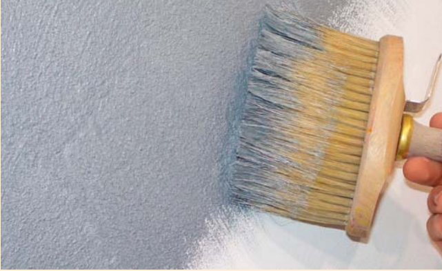
1) Auftrag mit der Streichbürste
