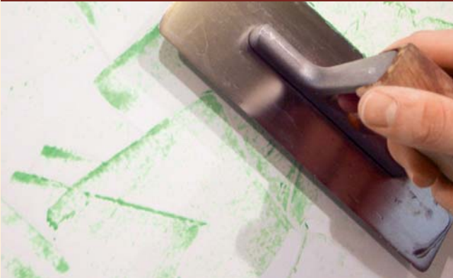
1) Auftrag mit der Venezianerkelle
